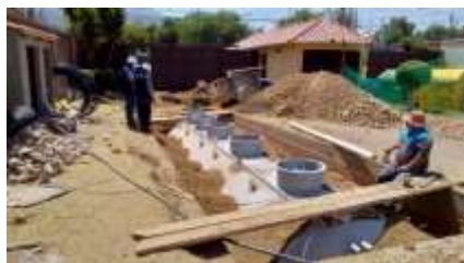
写真 10：150 人規模の小規模下水処理施設（STARD）建設の様子
